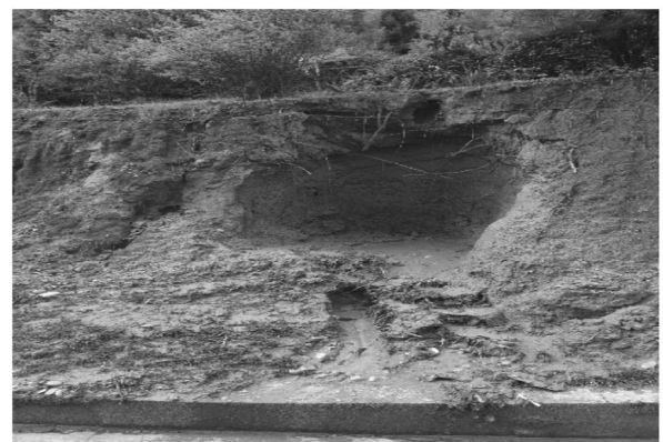
图 4 林芝市区公路边坡经上方林地径流冲刷形成的跌坎(马波摄于 20180813)
