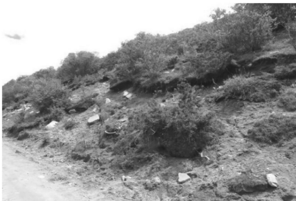
图 5 日多乡道路边坡的侵蚀情况(焦菊英摄于 20180817)
