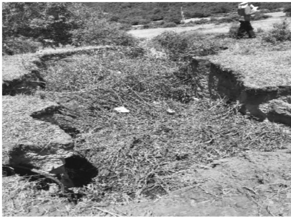
图 3 林芝市卡斯木村梯田的田面、田埂塌陷损毁情况(赵春敬摄于 20180813)
